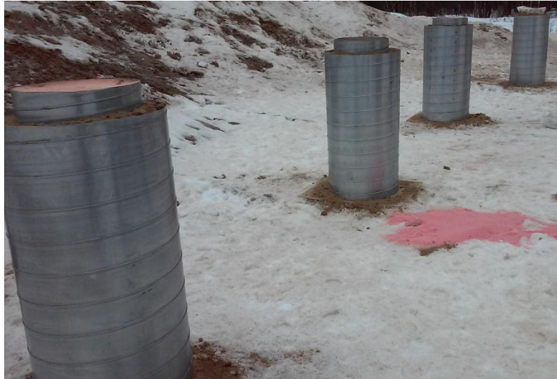
Рисунок 5.5 – Смонтированные пакеты на полигоне
