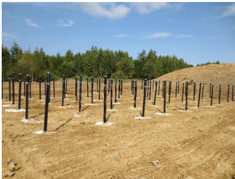
Рисунок 5.15 – Установленные на полигоне перед взрывом заготовки (50 шт.)
