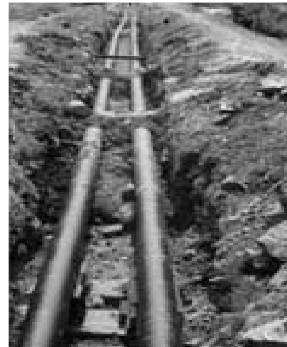
Рис. 4. Проложенная непрерывная 25-километровая линия.
