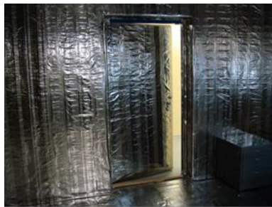
Рисунок 1 – (А) экранирующая камера для проведения высокоточных магнитных измерений; (Б) экранированное помещение
